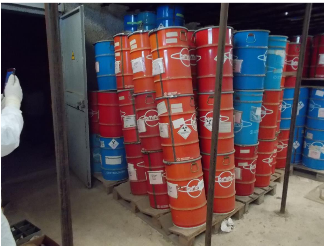
Figura 20: Fusti con stabilità precaria rimossi prioritariamente
