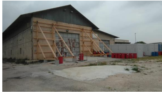
Figura 3 – deposito, vista lato Sud
